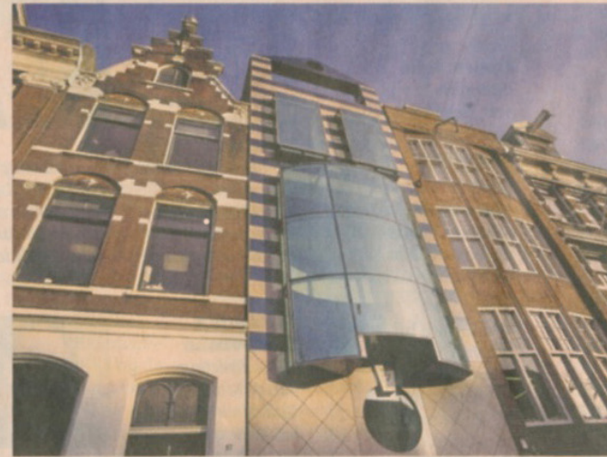
Links het pand aan het Rokin waar Het Gele Huis mogelijk wordt ondergebracht.
